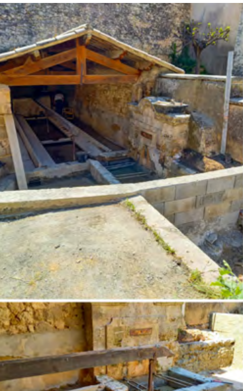
Travaux de restauration du lavoir
